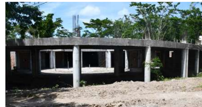
Vista principal estructural de la I etapa
