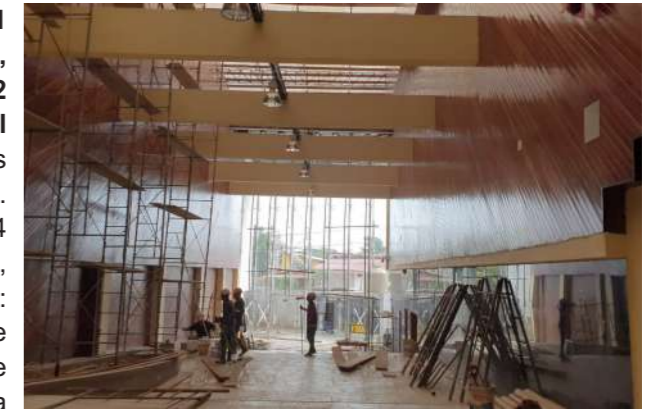
Persona trabajando en área de hall - Primer Piso
