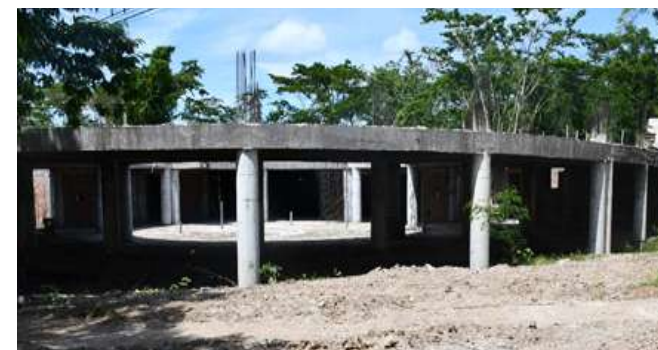
Vista principal estructural de la I etapa
