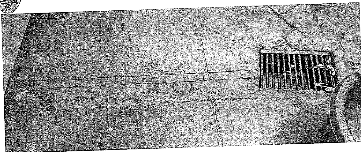
Planta de tratamiento de agua ( sin cerco de bioseguridad.)
