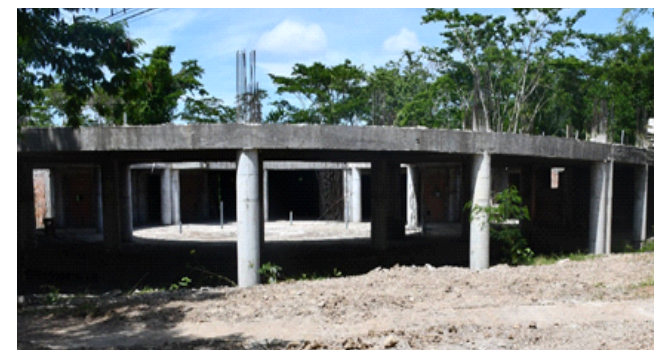
Vista principal estructural de la I etapa
