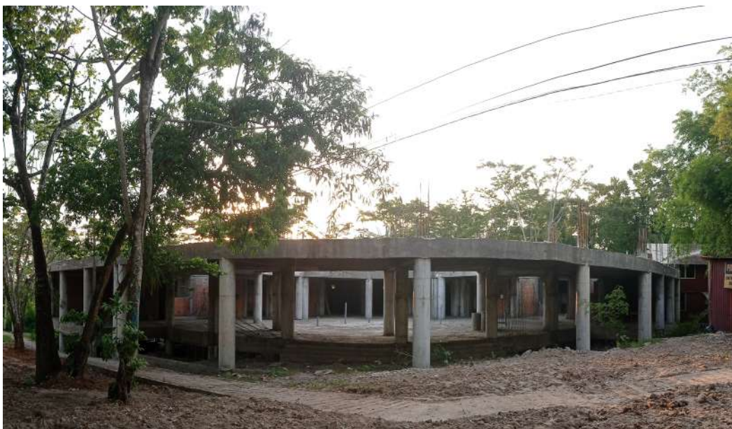
Vista estructural de la primera etapa de la Biblioteca Central
